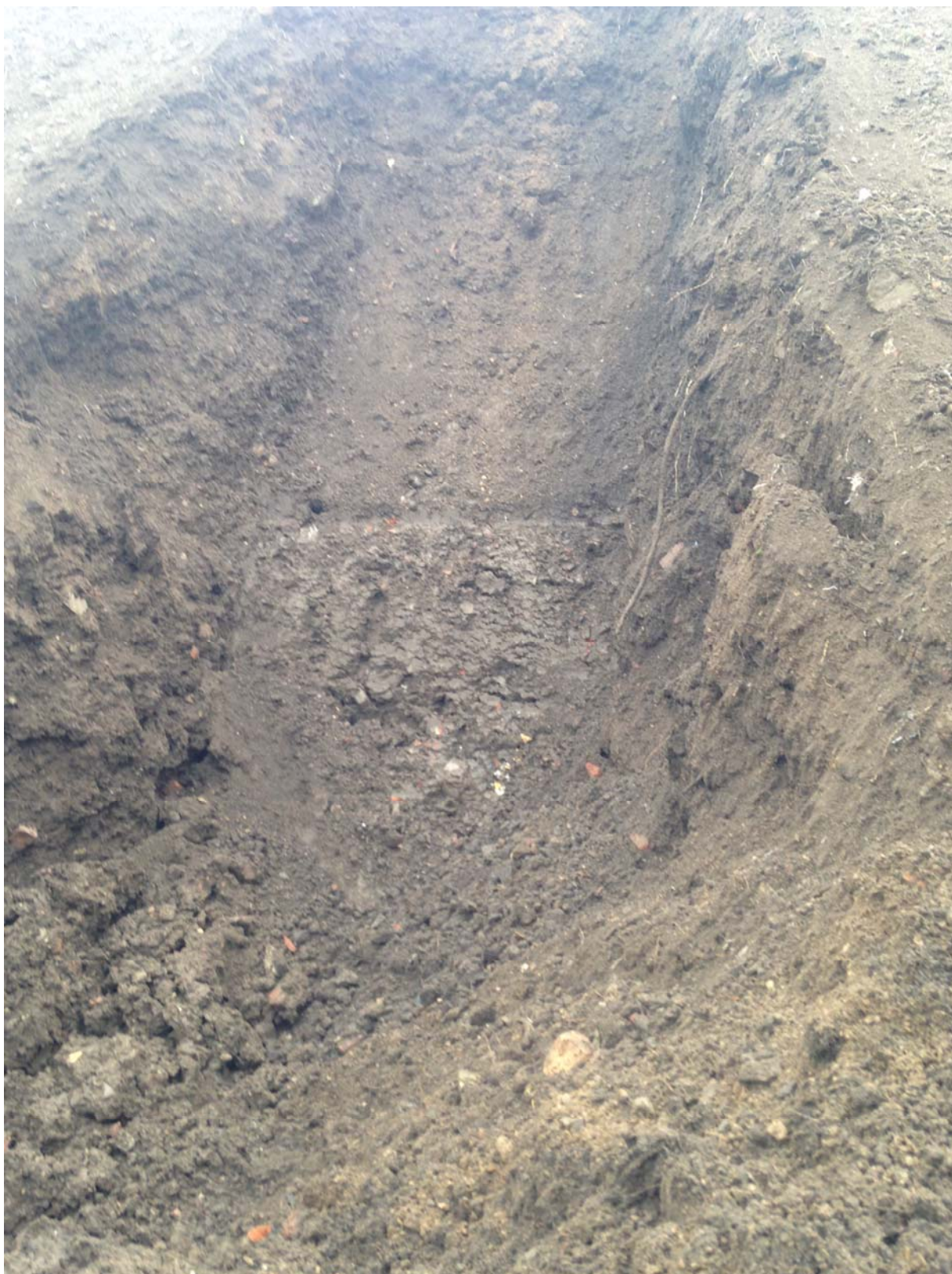
Bild 7: Auffüllung im Bereich des Schurfes
