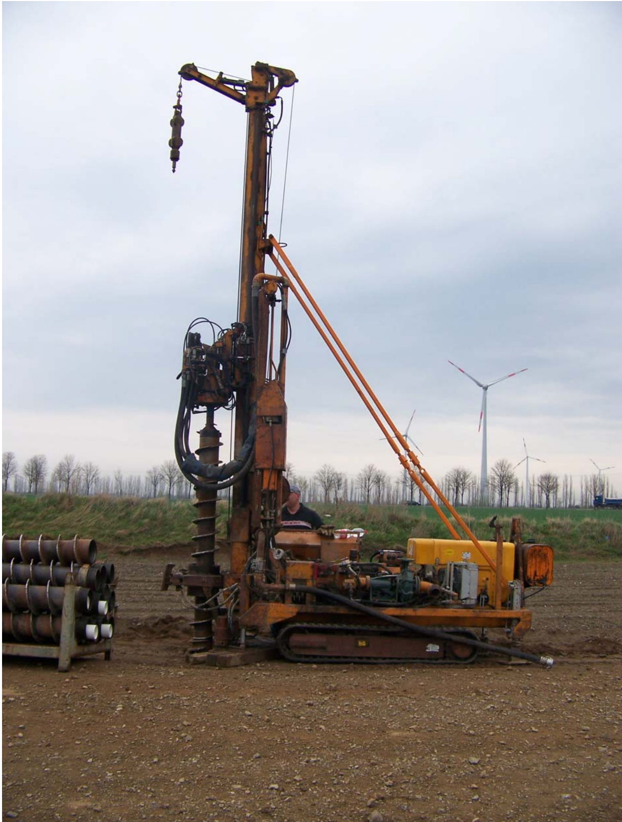
Bild 1: Beginn der Bohrung BP1 mit dem Raupenbohrgerät – DSB 0/3
